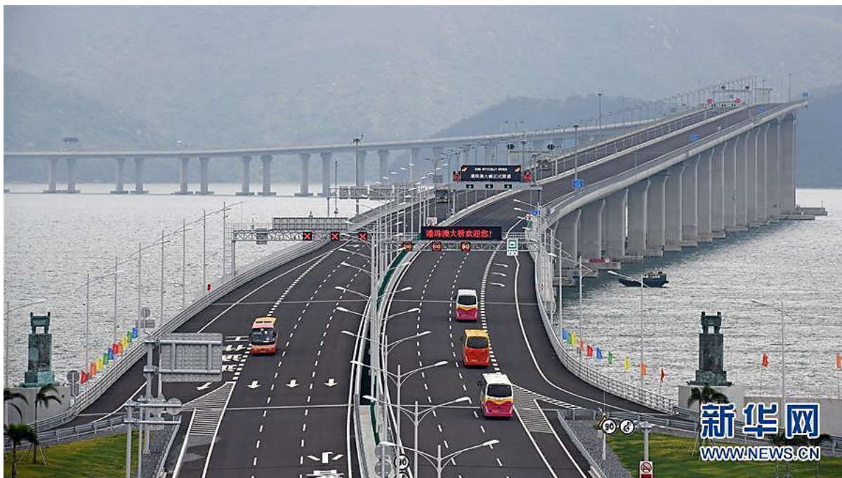
这是港珠澳大桥（2018 年 10 月 24 日摄）。新华社记者 梁旭 摄
